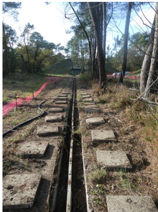
Type de dépose attendue – ici caniveaux BT-HT
